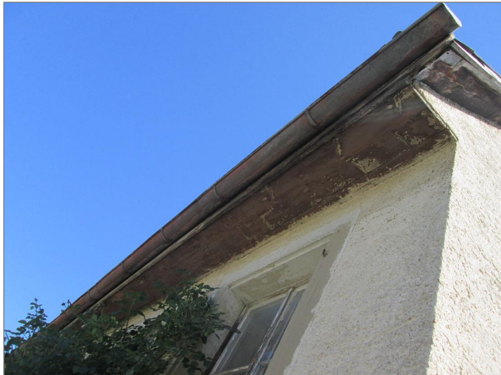
Abbildung 11: Dachvorsprung am Wohnhaus ohne Nester von Gebäudebrütern (Foto: HPC AG, 09.07.2018)
