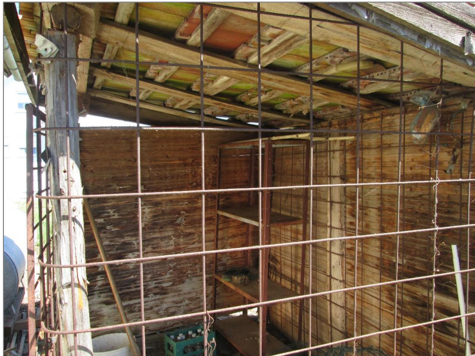
Abbildung 10: Halb offener Schuppen/Hundezwinger (Foto: HPC AG, 09.07.2018)
